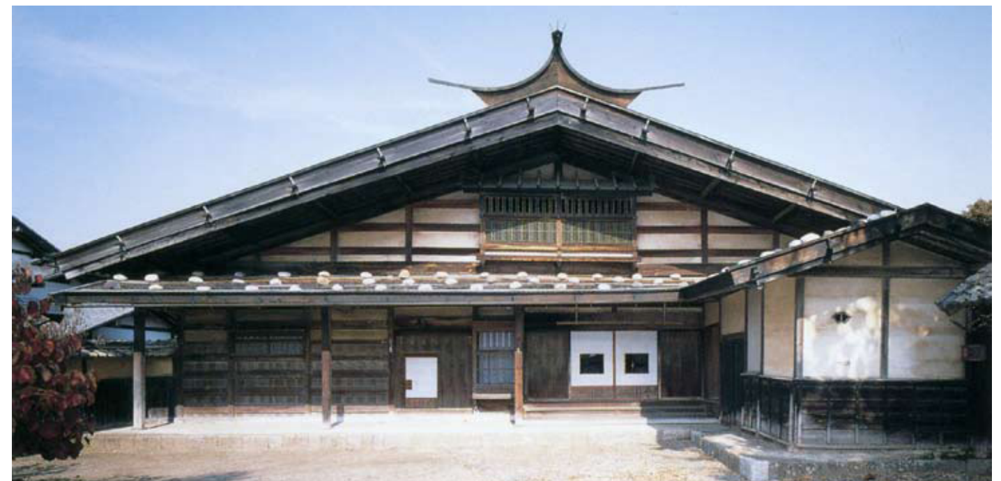
18世紀後半に建築された代表的な本棟造りの堀内家住宅（重要文化財）。
