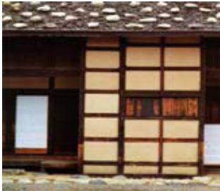
民家(旧新井邸住宅)
