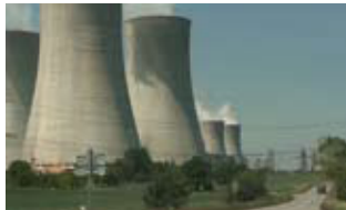
原子力発電所
