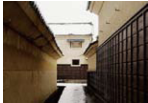
土壁を守る深い庇
