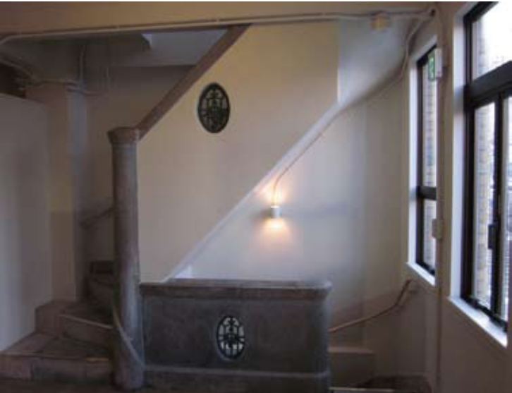
2階階段室と透し彫り金物
