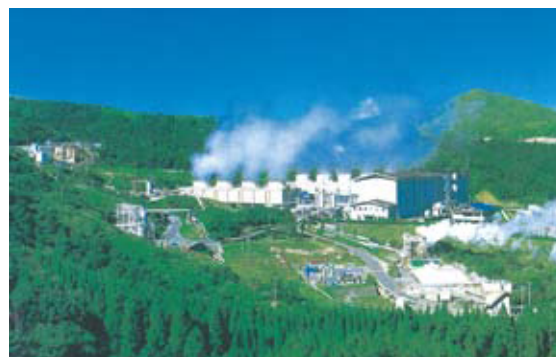
八丁原地熱発電所
